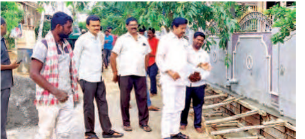
డ్రైనేజీ నిర్మాణ పనులను పరిశీలిస్తున్న ఎంఎల్ఐ సామినేని ఉదయభాను
